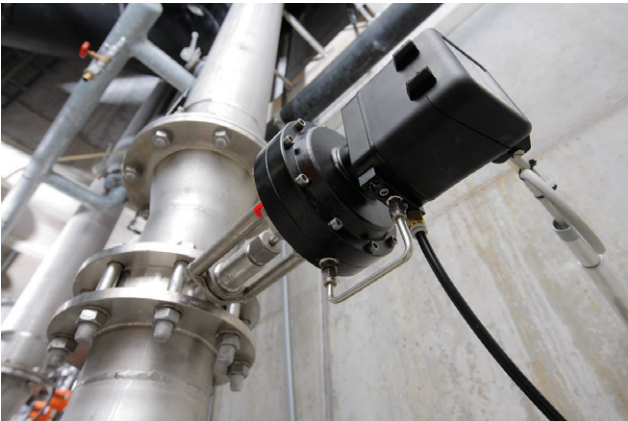
Gleitschieberventil zur Regelung des Sauerstoffgehalts in der Biologie
